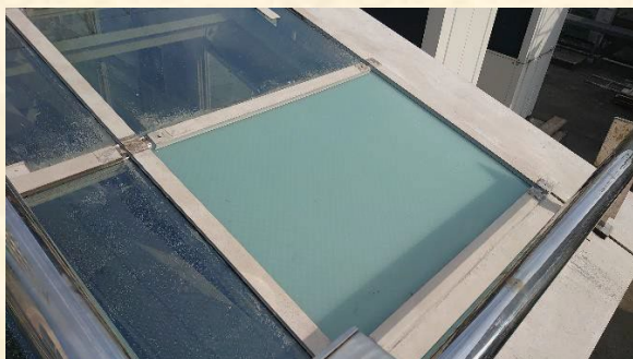
【試験施工を行い確認】
